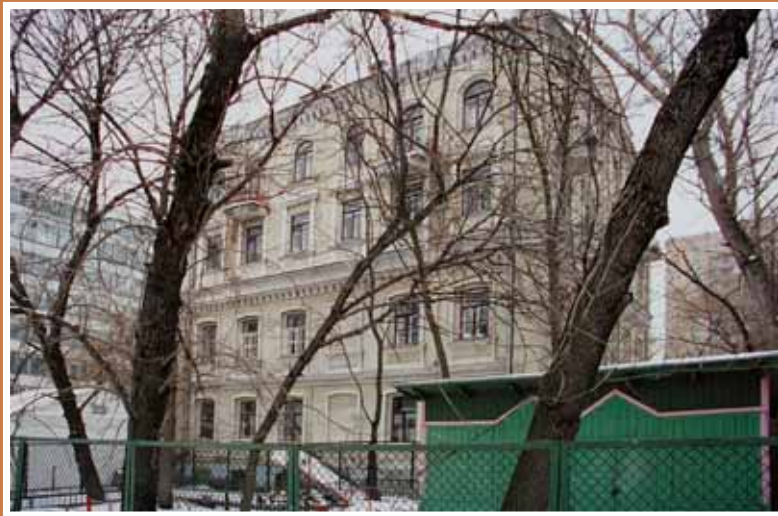
Здание богадельни церкви свв. апп. Петра и Павла на Новой Басманной. Вид со двора
