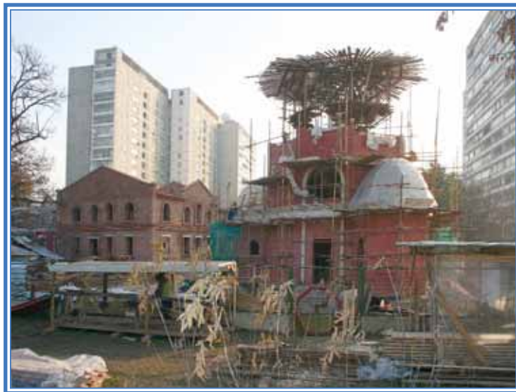
Строительство Крестовской часовни и дома причта. Фото 2007 года
